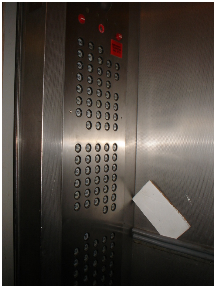
آسانسور برج سیرز
